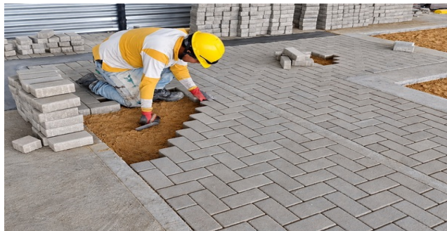
Instalación y acabados exteriores
